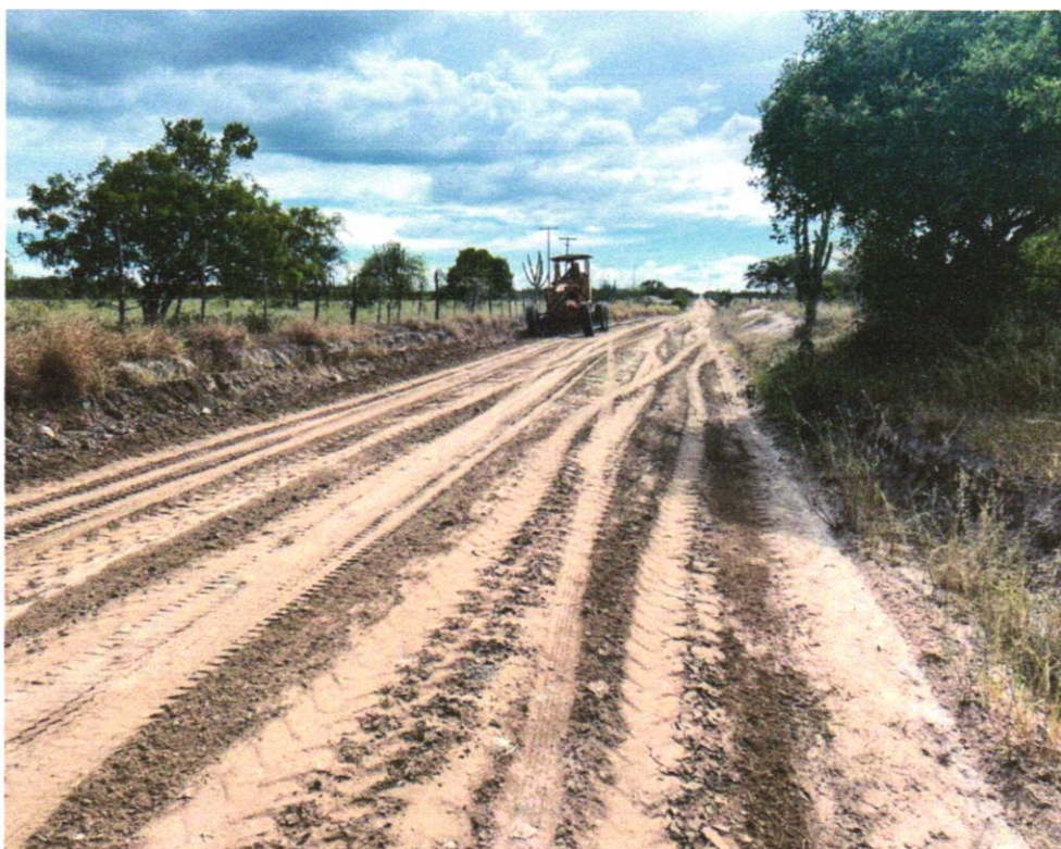
FOTO 03 - ESCAVACAO E CARGA MATERIAL 1A CATEGORIA, UTILIZANDO TRATOR DE ESTEIRAS DE 110 A 160HP COM LAMINA, PESO OPERACIONAL * 13T E PA CARREGADEIRA COM 170 HP
