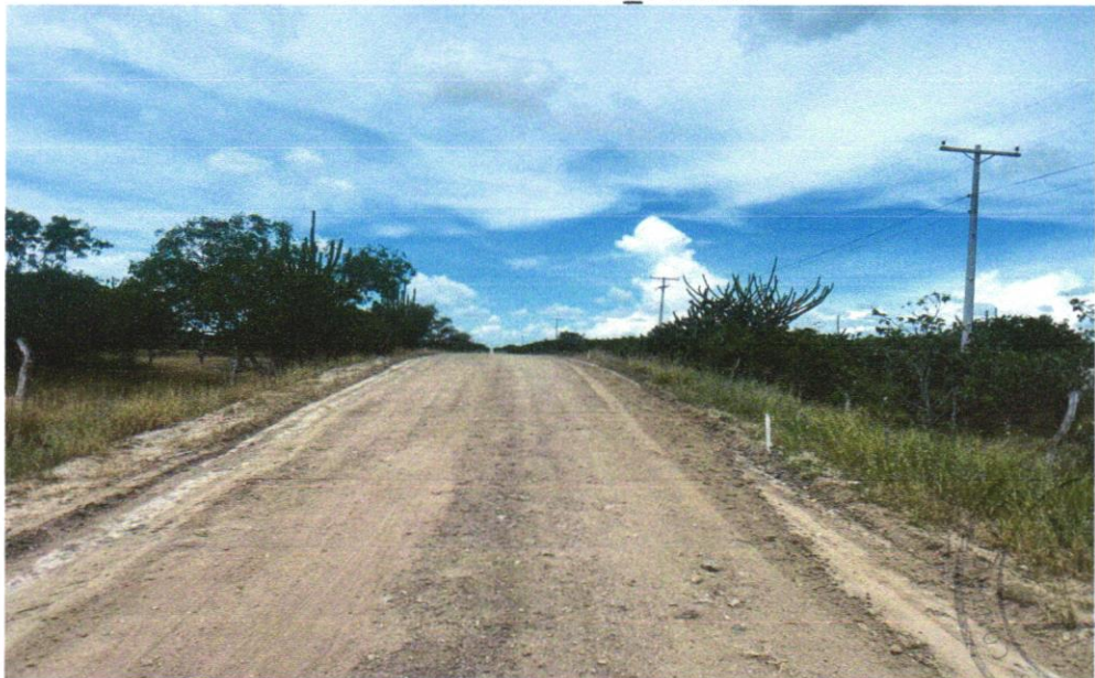
Foto 10 - EXECUÇÃO E COMPACTAÇÃO DE ATERRO COM SOLO PREDOMINANTEMENTE ARGILOSO - EXCLUSIVE SOLO, ESCAVAÇÃO, CARGA E TRANSPORTE. AF_11/2019
