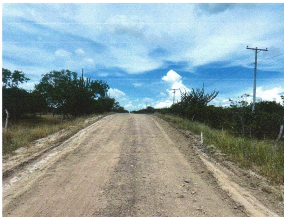
FOTO 01 – REGULARIZAÇÃO DE SUPERFÍCIES COM MOTONIVELADORA. AF_11/2019
